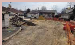
En cours de travaux
