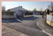
Fin de travaux
