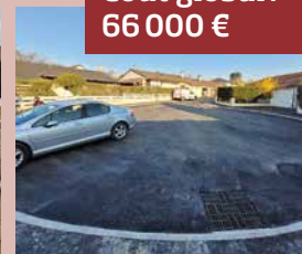
Fin de travaux
