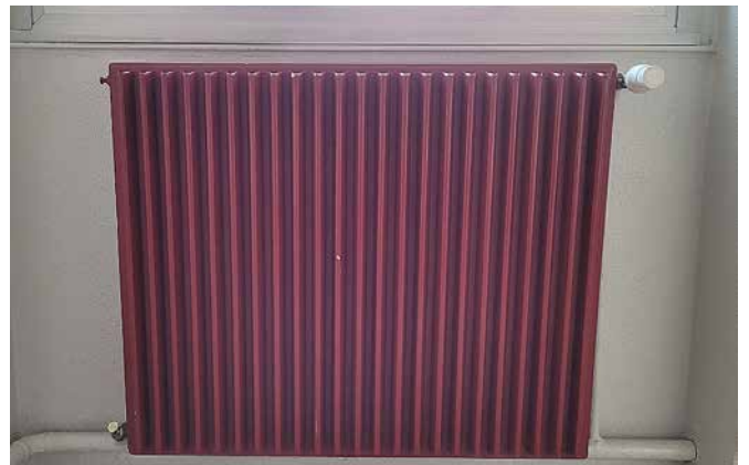
▲ Mise en place de 70 robinets thermostatiques et coudes de réglage équerre pour les radiateurs de l'École Marcel Pagnol : 10 700 €
